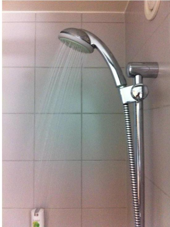
**ADVERTÊNCIA: PARA GARANTIR O BOM FUNCIONAMENTO DO LOWFLOW, A PRESSÃO DA ÁGUA À ENTRADA DEVE SER IGUAL OU SUPERIOR A 4.5 bar E A CABEÇA DO CHUVEIRO NÃO DEVE TER QUALQUER TIPO DE ESTRANGULAMENTO INTERNO.**
